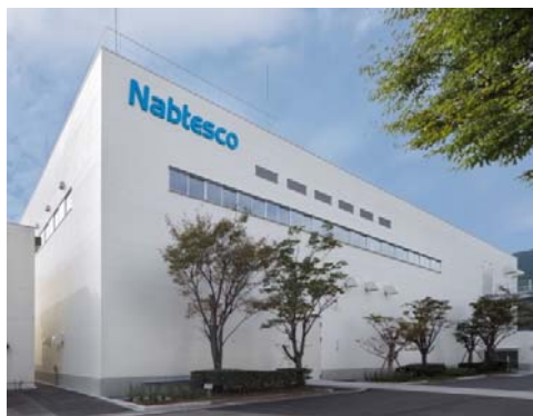
EHSV 棟（延床面積 5,101 m 2 ）
