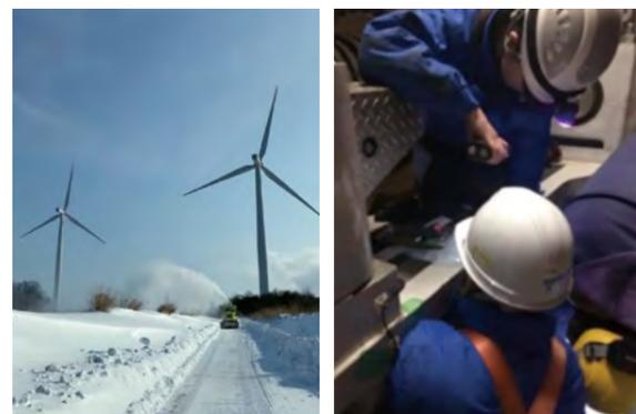
北海道央地域で行った風力発電機実機での検証作業。風車内部に入り、高さ70~80mまで登って検証機を取り付ける
