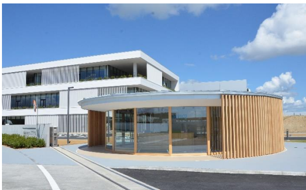
地元の天竜杉を使用した守衛所
