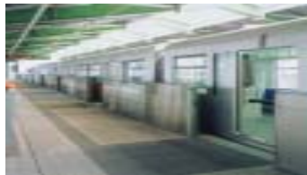
【多摩モノレール プラットホームドア】
