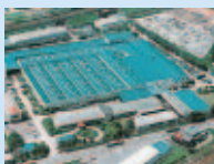
岐阜第二工場 (TS Corporation)
