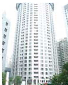
上海現地法人入居ビル
