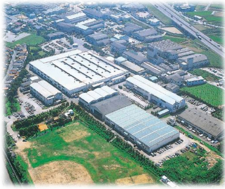
西神工場（兵庫県神戸市西区）／船用カンパニー マザー工場
